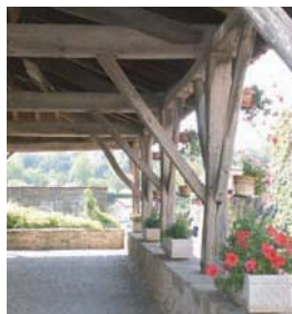
Halle de Saint-Pardoux
